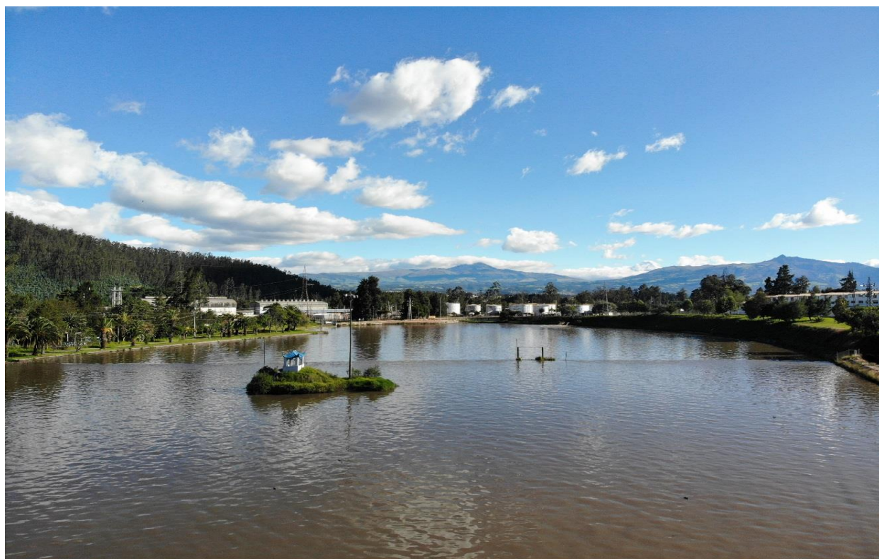
Foto: Central Hidroeléctrica Guangopolo.
